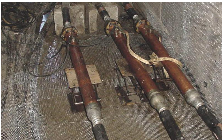
Figure 59 - Equipotential zone using wire mesh
