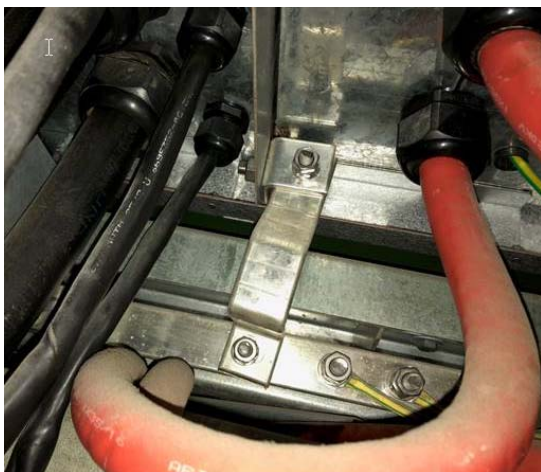
Earth bar (KL installation)
